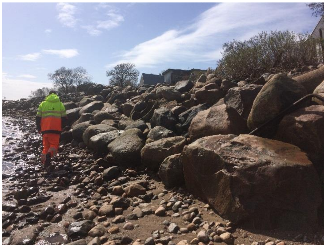
Figur 7-36 Stenskonung utanför fastigheterna på Simmarevägen
