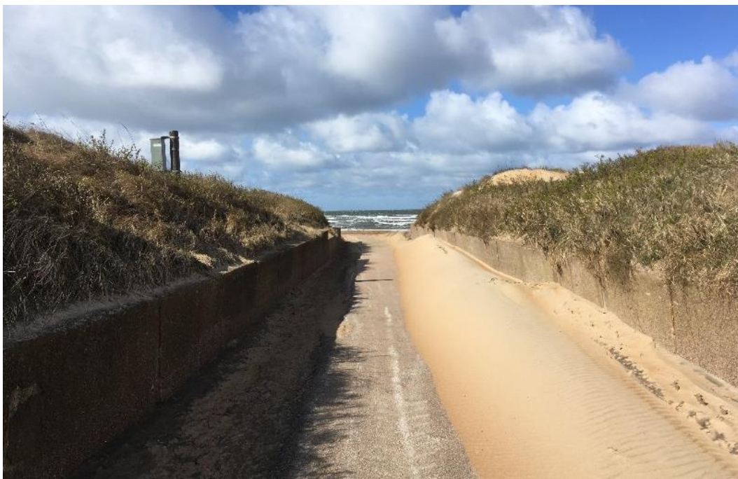
Figur 7-47 Räddningsväg förstärkt med betongväggar
