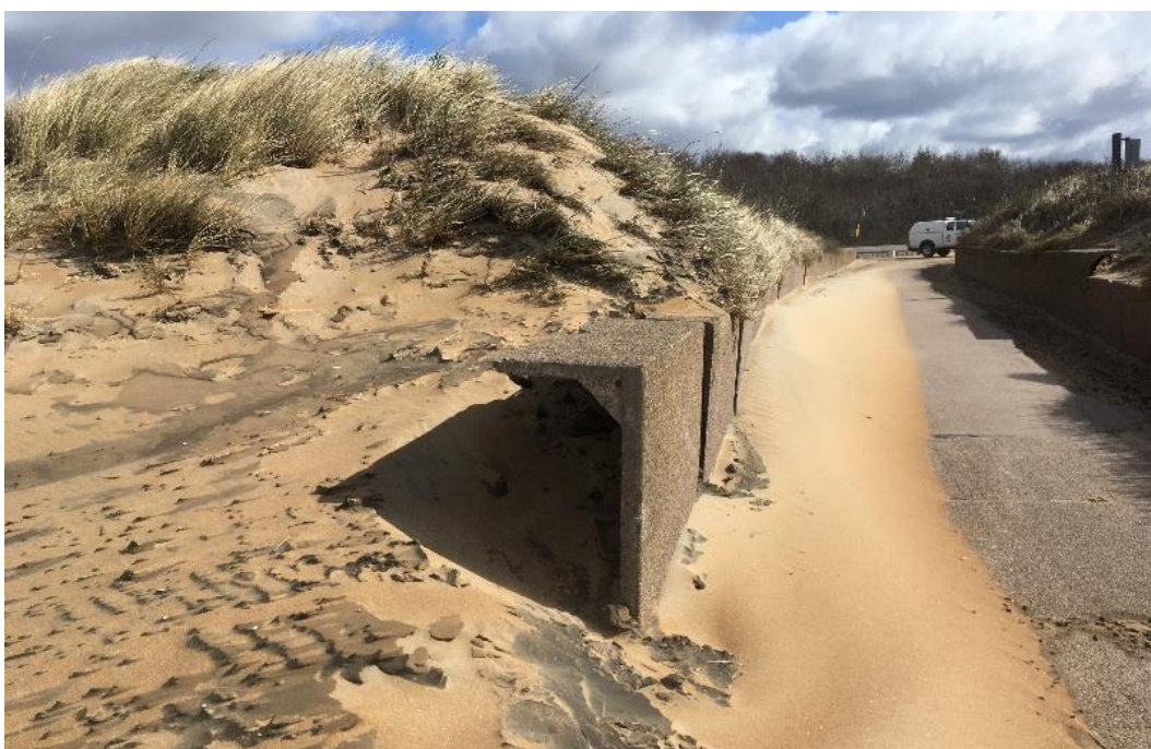
Figur 7-48 Erosion på dyner vid anslutning till betongvägg
