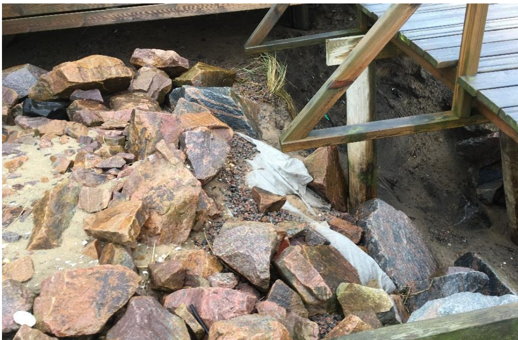
Figur 7-25 Fiberduk och finmaterial från stenskoning synligt i dagen
