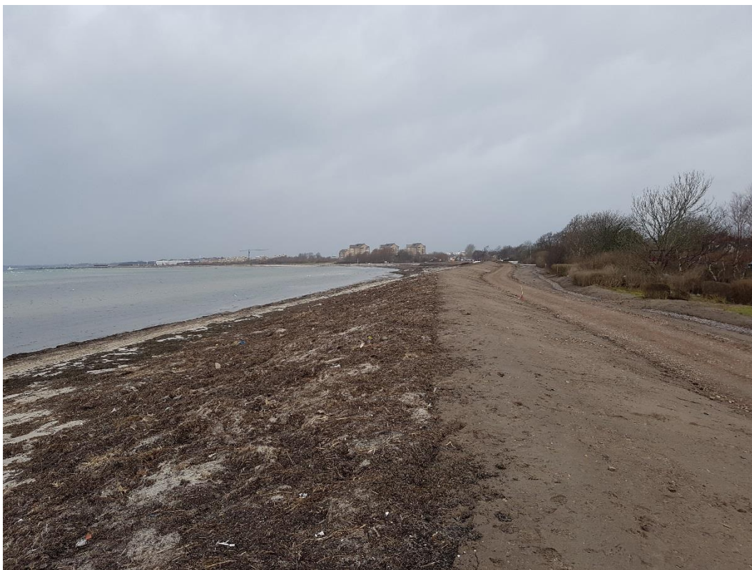
Figur 6-1 Nyligen anlagd översvämningvall i Lomma kommun. På sikt kommer vallen att täckas av vegetation.
