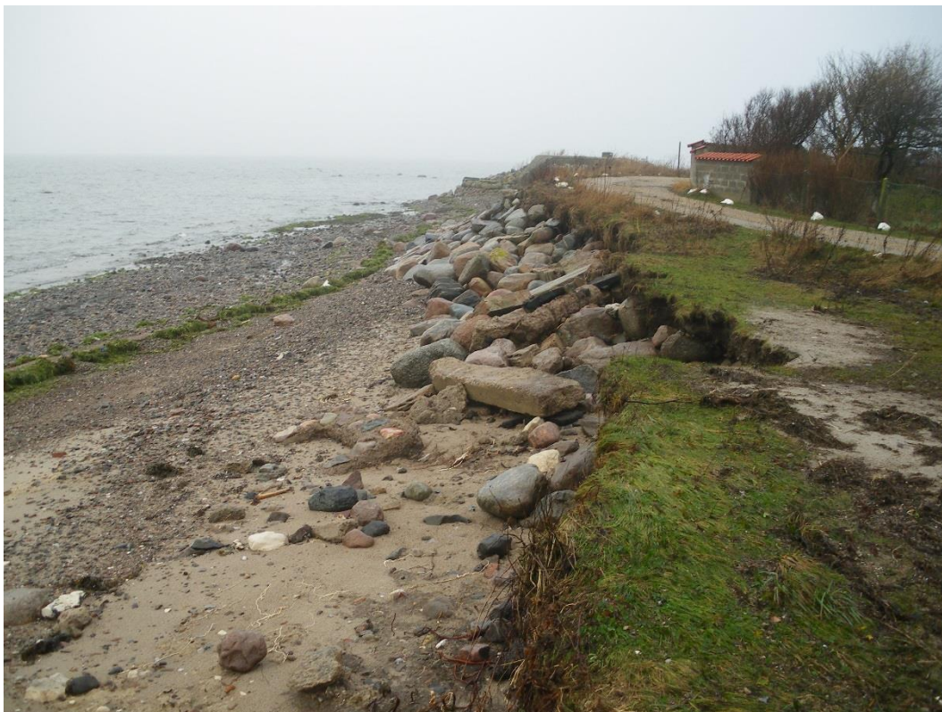
Figur 6-6 Exempel på stenskoning som underminerats och drabbats av sättning i samband med storm.
