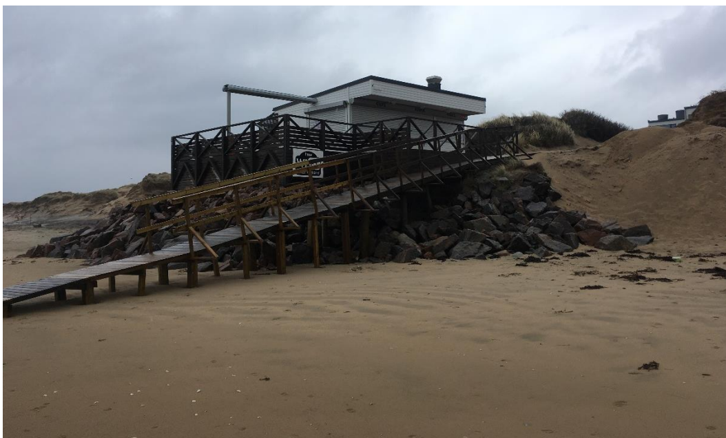
Figur 7-24 Stenskoning och sandpåfyllnad vid kiosken
