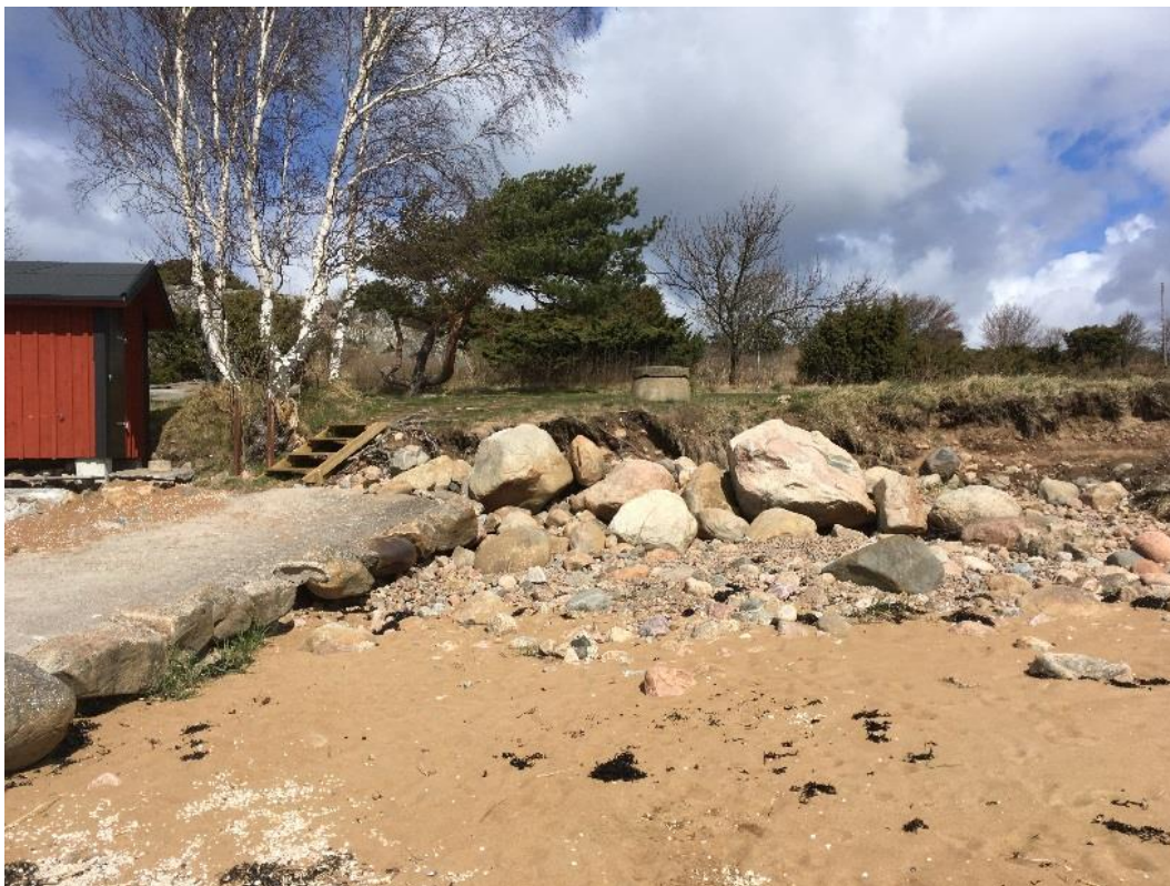
Figur 7-57 Rasbrant på 1 m efter stormerosion, norra delen av Laxviksstrand
