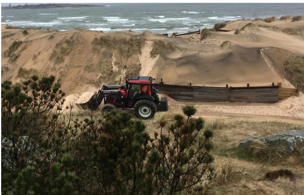
Figur 7-26 Rensning av sand från räddningsväg. Ny sand frigörs från den branta dynen och trillar ner på vägen.
