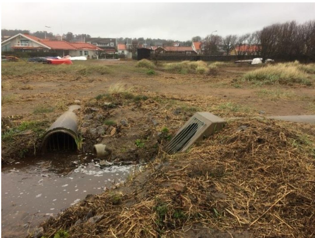
Figur 7-11 Dagvattenutlopp förstärkta med krossmaterial
