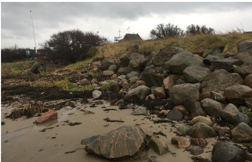
Figur 7-15 Underdimensionerad, felaktigt anlagd, stenskoning som skydd för campingen
