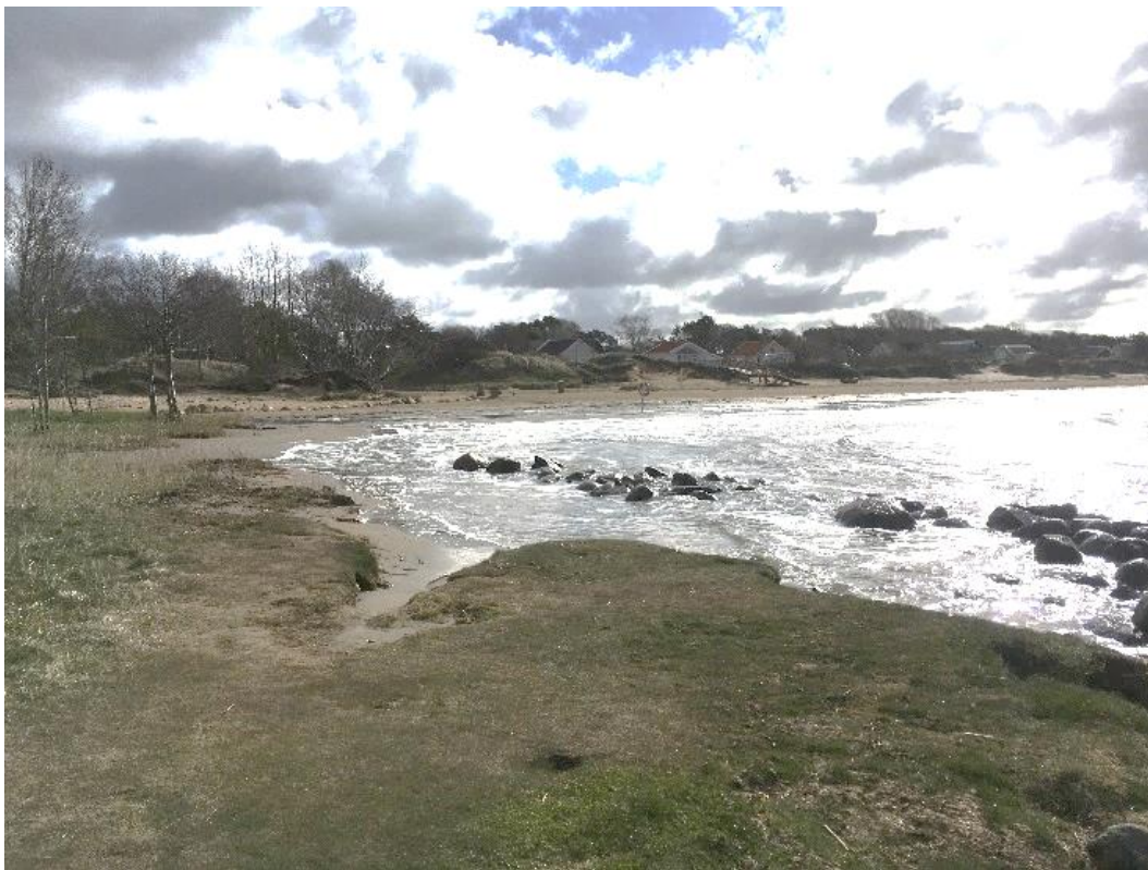
Figur 7-40 Stenskoningens slut in mot stranden med tydliga erosionsbranter bakom
