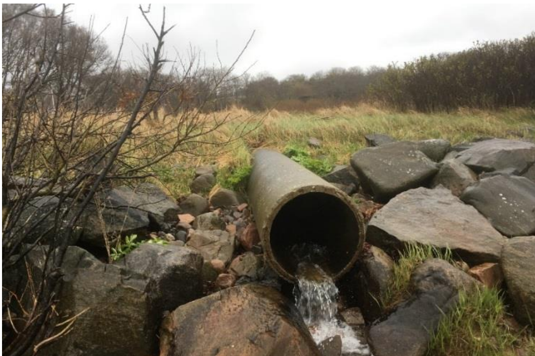
Figur 7-4 Dagvattenutlopp där cirka 3 m kulvert är synligt
