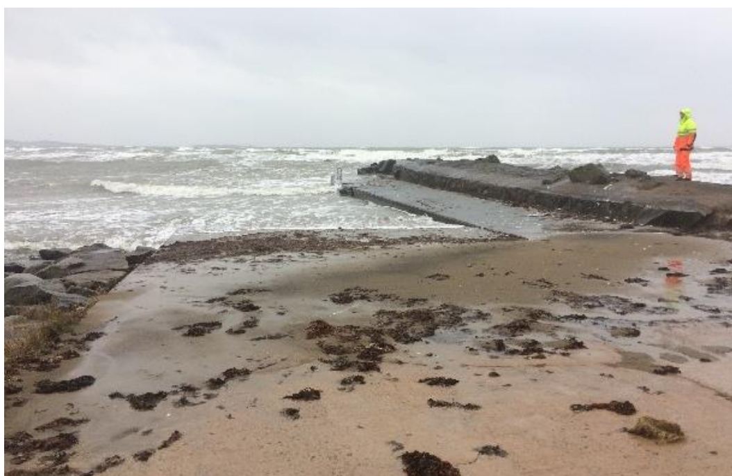
Figur 7-20 Stenbrygga/sjösättningslip i norra Ringenäs
