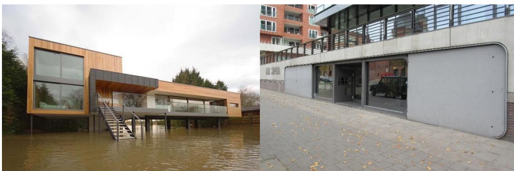
Figur 6-7 Exempel på översvämningsanpassad bebyggelse. Till vänster en upphöjd byggnad och till höger byggnad där bottenvåningen kan stängas av vid översvämnings-situationer, med en upphöjd gångväg en våning upp.
