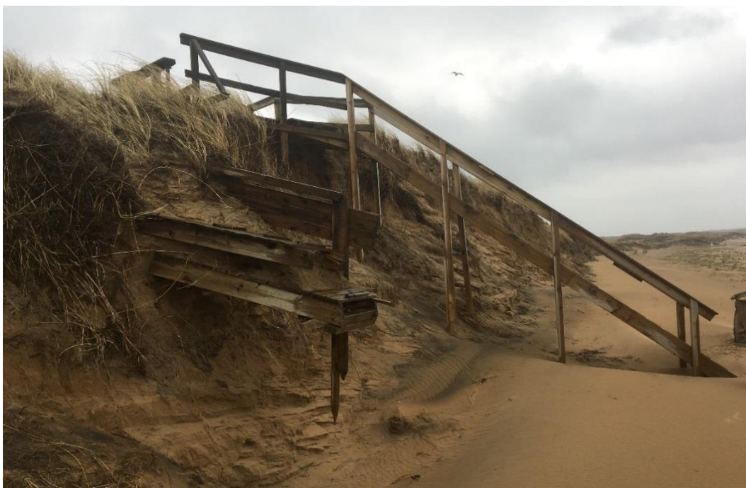
Figur 7-23 Äldre träkonstruktion sticker ut från dynen. Bakom når nuvarande träspång inte längre ner i sanden
