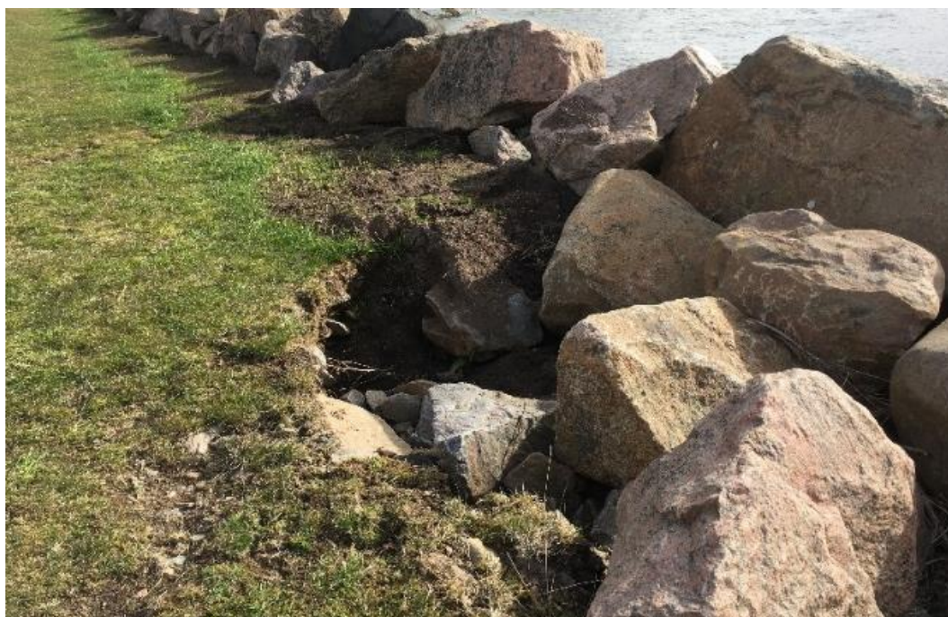
Figur 7-39 Erosion ovanför stenskoningen vid Handikappbadet
